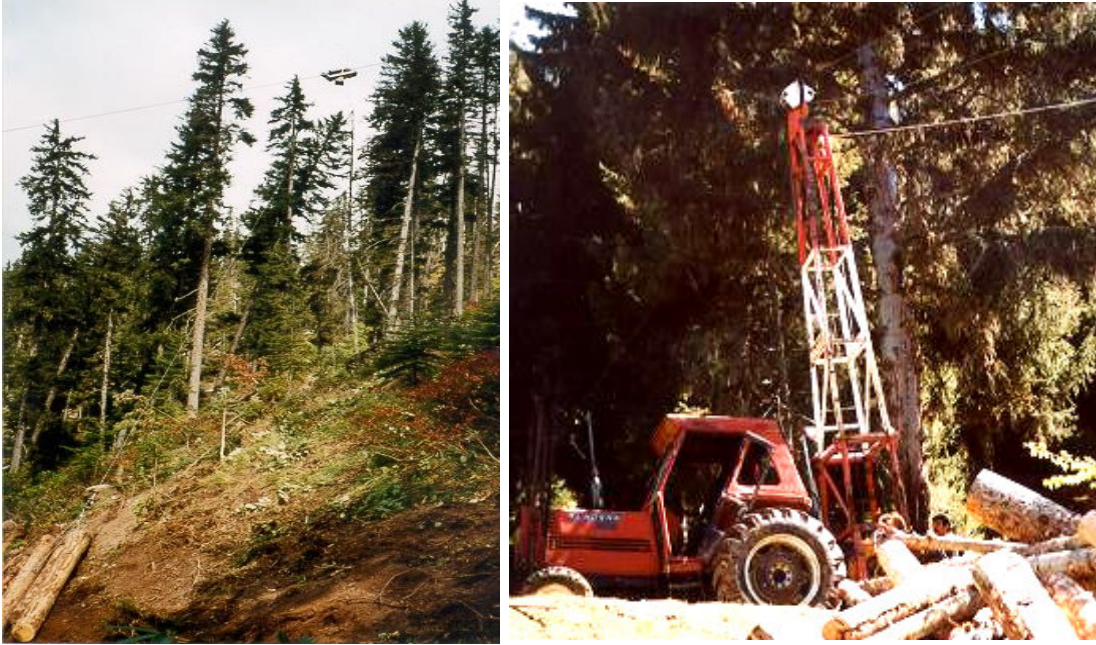
Şekil 2. Koller K300 kısa mesafeli orman hava hattı ile bölmeden çıkarma
